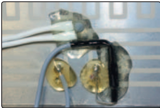
Die Anschlüsse der Heizplatte sind verlötet und mit Klebstoff gesichert. Oben im Bild ist der Temperatursensor zu erkennen
